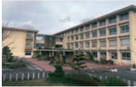
大野町小中学校空調設備整備事業(岐阜県)
